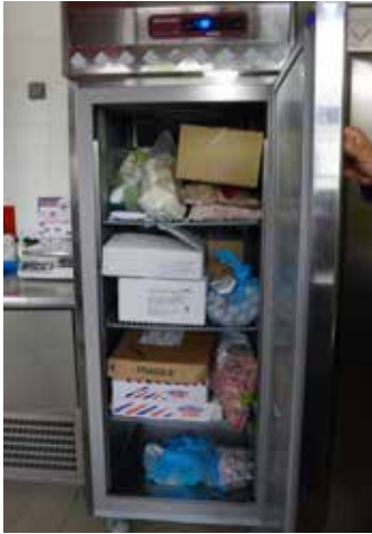
REEMPLACEMENT D'UNE ARMOIRE FROIDE AU RESTAURANT SCOLAIRE
