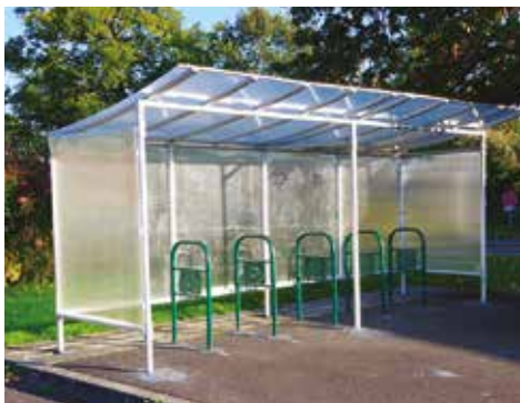
INSTALLATION D'UN ABRI VÉLOS À L'ÉCOLE
