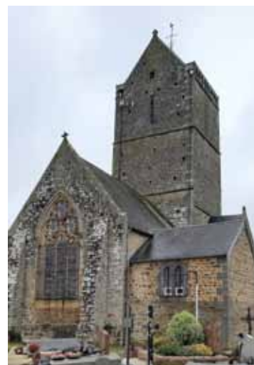
• Extraction de fientes de pigeons dans le clocher de l'Eglise (1 photo)
